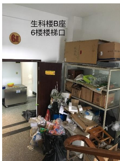
生科楼 6 楼 B 座楼梯口—堆放物品阻挡消防通道
