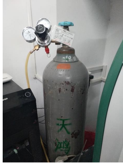
逸夫楼 4020—气瓶未固定
