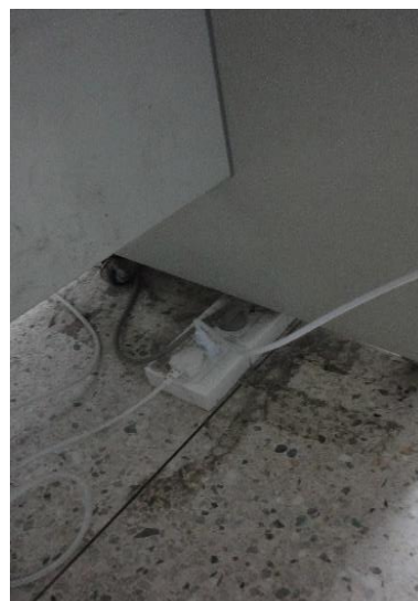
生科楼 C2020—接线板直接放置于地面使用
