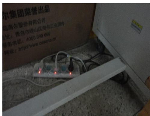
生科楼 C2020—接线板直接放置于地面使用
