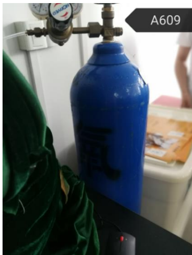
理科楼 A609—氧气气瓶和乙炔气瓶放在同一房间内，距离不超过 3 米，且氧气气瓶未固定
