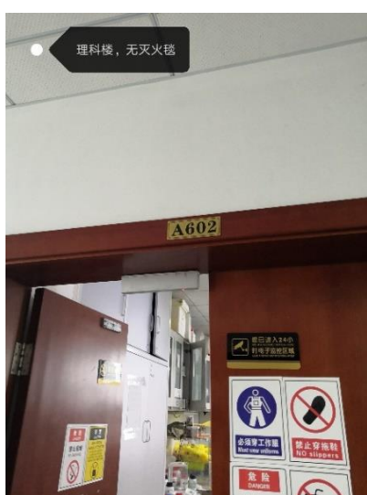
理科楼 A602—实验室无灭火毯
